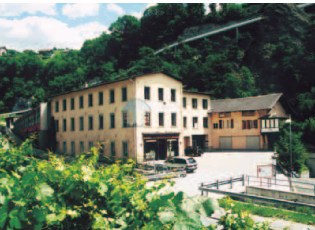
Die neue Cybox-Fabrik befindet sich in der ehemaligen Möbelfabrik Reichenbach an der Sionne in Sitten.
